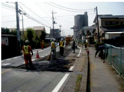
区内の道路修繕の様子
